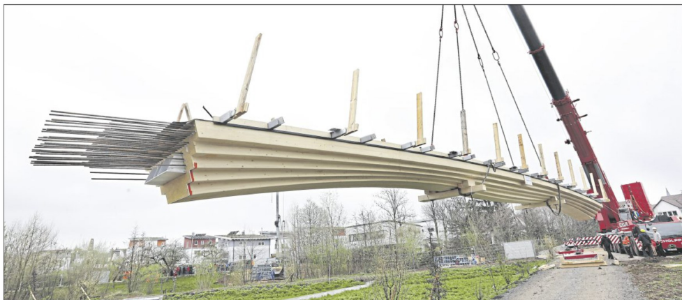
Am Kran schwebte die 25 Tonnen schwere und 30 Meter lange Brücke am Freitag an ihren Platz, wo sie den Urbach überspannt.
