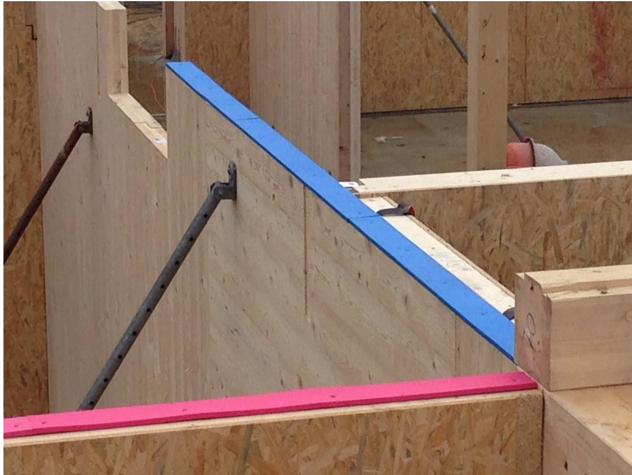
Schallschutzlager im Holzbau
